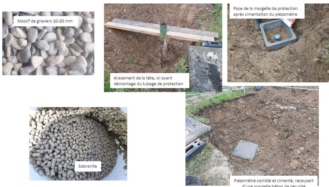
Figure 30 : Photographie des travaux de comblement du PZ1 en juin 2021 (Source : Ante Group)
