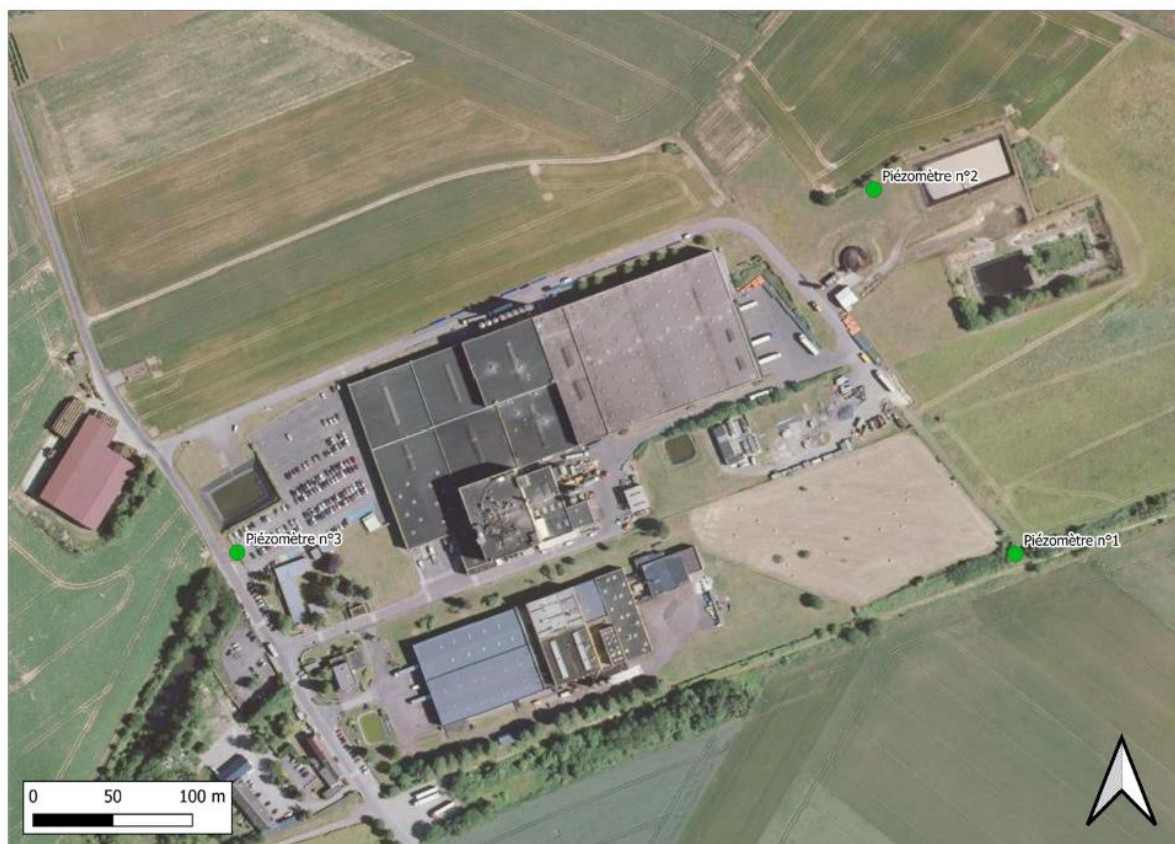
Figure 8 : Localisation des piézomètres créés en 2022 au sein du site Dailycer sur vue aérienne (non disponible en actualisée depuis les travaux) Source Anteagroup
